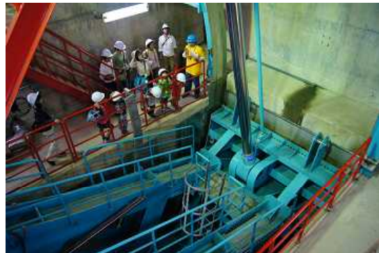
じょうようこうずいば 常用洪水吐きゲート設備見学の様子
