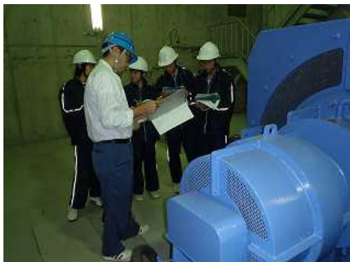
電気通信設備点検中!
