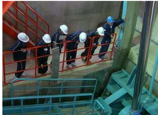
機械設備点検中!
