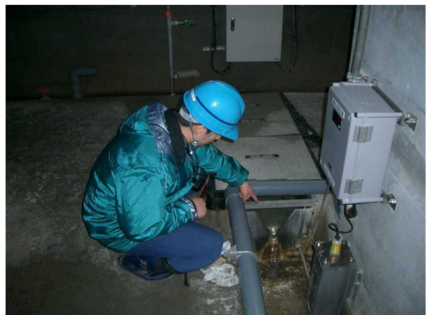
堤体内点検（漏水量）状況
