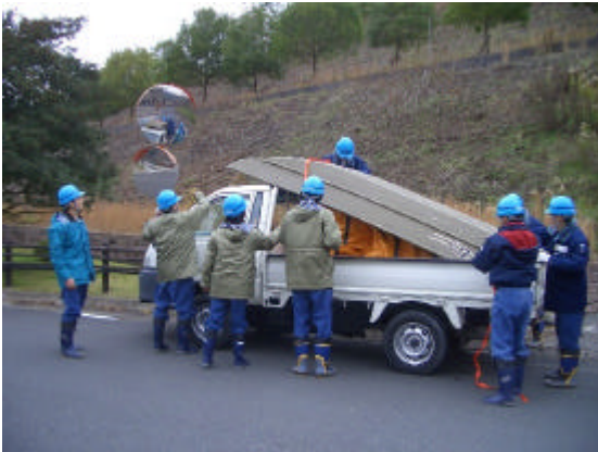
資材積込み状況
