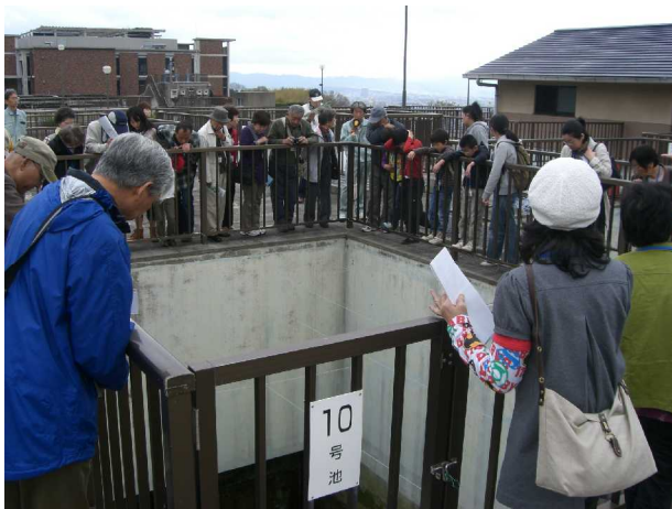
（乙訓浄水場「急速ろ過池」の見学）
