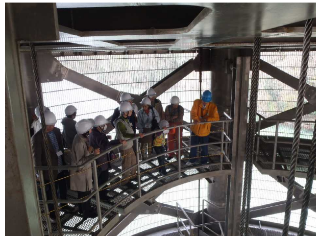
（日吉ダム「選択取水設備」の見学）
