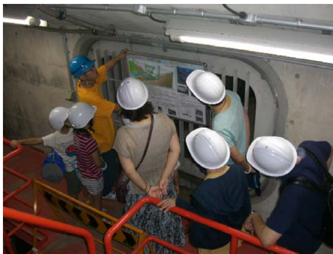
常用洪水吐きゲート室にて
