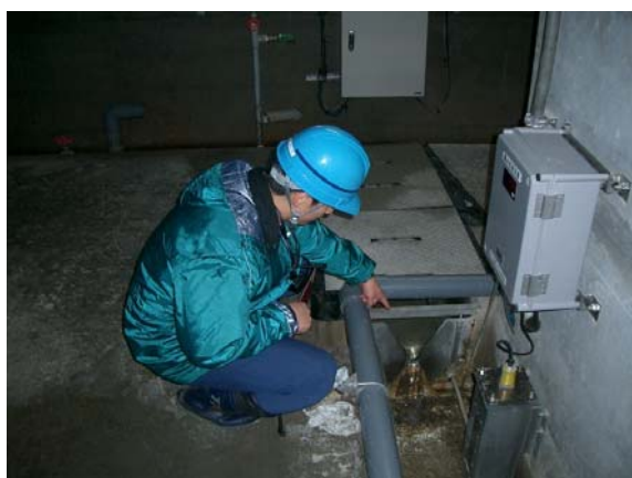
堤体巡視・点検状況
