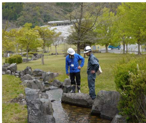
ダム下流広場にて安全点検
