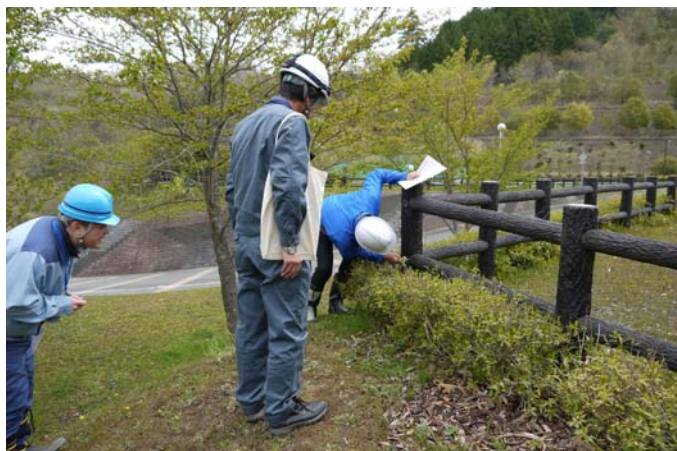
柵の破損等がないか確認
