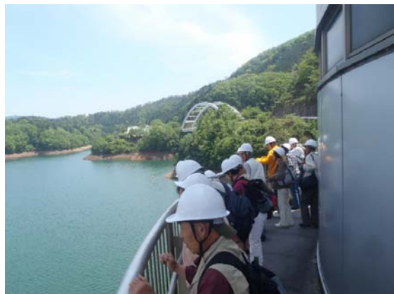
（日吉ダム「選択取水設備」からダム湖を望む）
