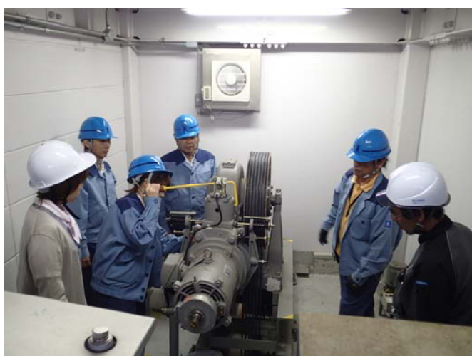
(エレベータ操作訓練)
