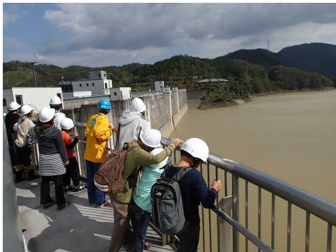
取水塔からダム湖を望む
