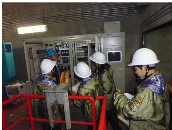
常用洪水吐きゲート点検
