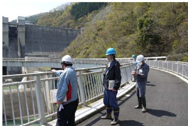
円形橋の点検
