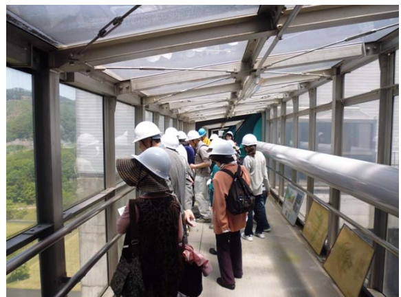
日吉ダム非常用洪水吐きゲート室
