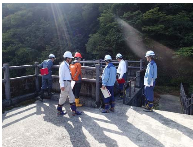
世木ダム天端周辺の点検
