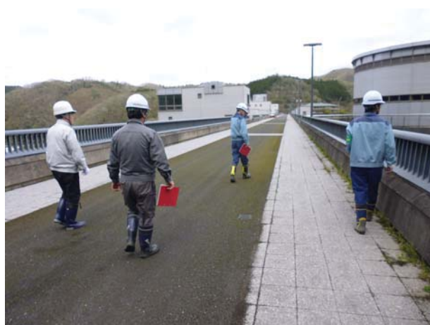
ダム堤体天端の点検状況
