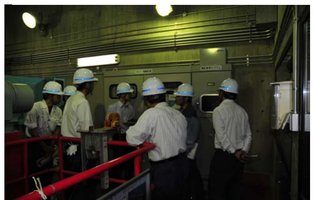
機側操作によるゲート操作演習
