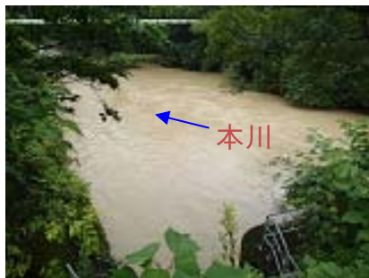
⑥新庄発電所放流口
