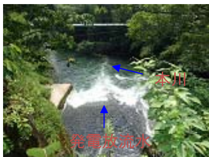
⑥新庄発電所 放流口
