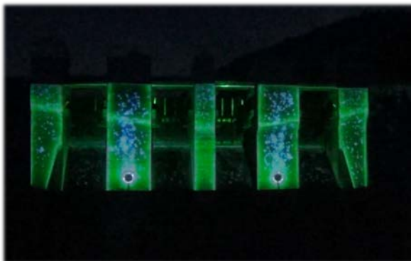
凹凸を利用し美しく照らし出された日吉ダムのゲート
