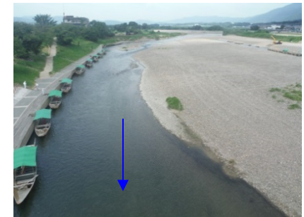
⑨保津橋上流
