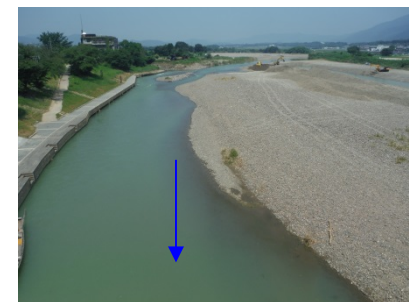
⑨保津橋上流
