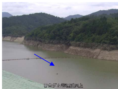
③日吉ダム貯水池
