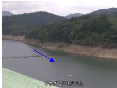
③日吉ダム貯水池
