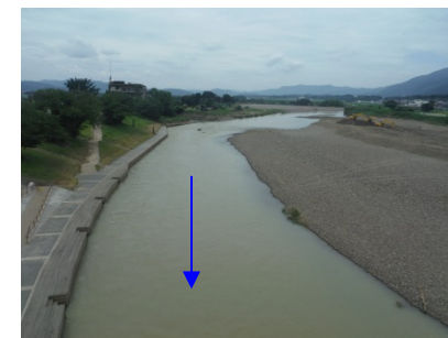
⑨保津橋上流
