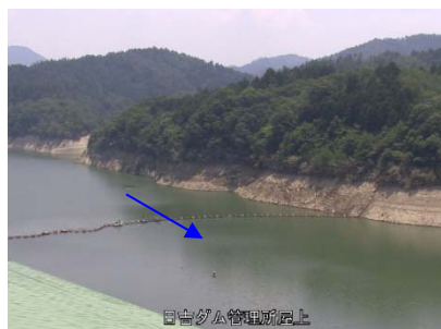
③日吉ダム貯水池
