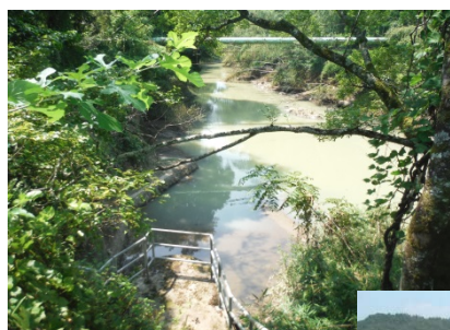
⑥新庄発電所 放流口(停止中)
