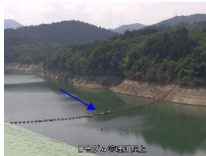
③日吉ダム貯水池
