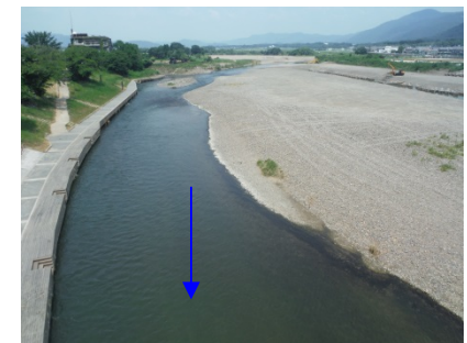
⑨保津橋上流
