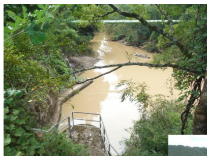
⑥新庄発電所 放流口(停止中)
