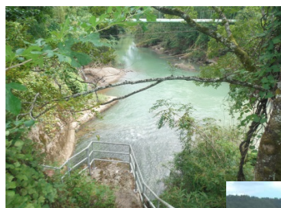
⑥新庄発電所 放流口(停止中)
