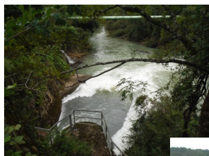
⑥新庄発電所 放流口(運転中)
