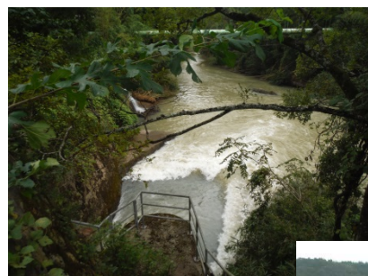
⑥新庄発電所 放流口(停止中)
