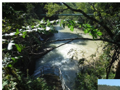
⑥新庄発電所 放流口(運転中)
