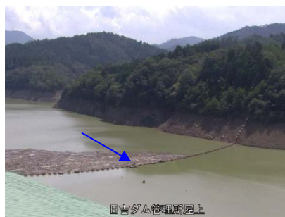
③日吉ダム貯水池
