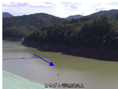
③日吉ダム貯水池
