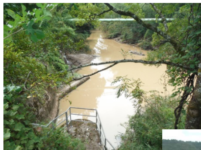
⑥新庄発電所 放流口(停止中)
