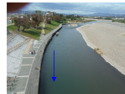
⑨保津橋上流
