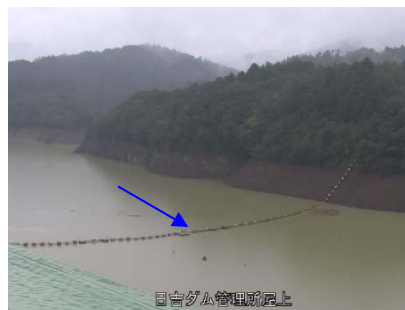
③日吉ダム貯水池
