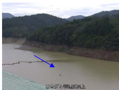
③日吉ダム貯水池
