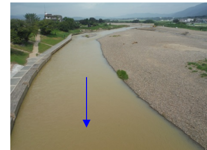
⑨保津橋上流
