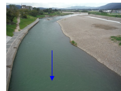
⑨保津橋上流
