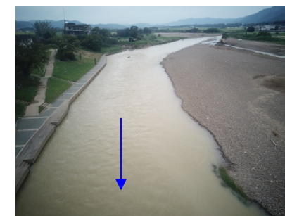
⑨保津橋上流
