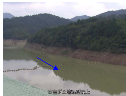
③日吉ダム貯水池
