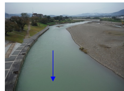
⑨保津橋上流
