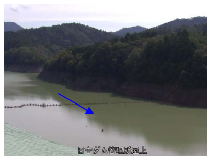
③日吉ダム貯水池
