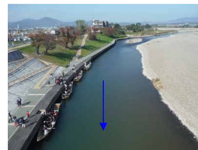
⑨保津橋上流
