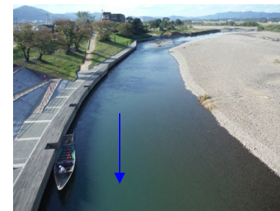
⑨保津橋上流
