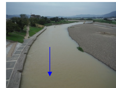
⑨保津橋上流
