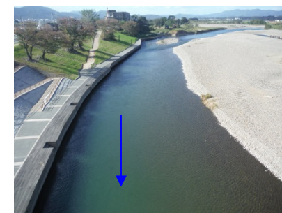
⑨保津橋上流
