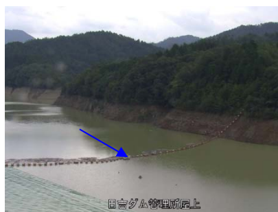
③日吉ダム貯水池
