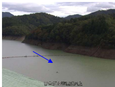
③日吉ダム貯水池
