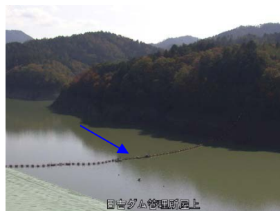
③日吉ダム貯水池
