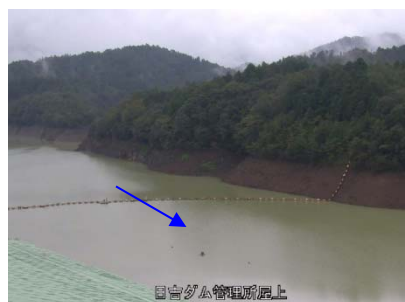
③日吉ダム貯水池
