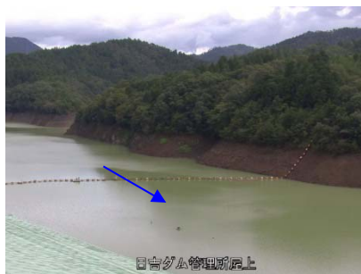
③日吉ダム貯水池
