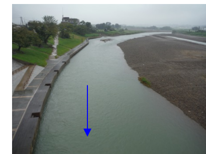
⑨保津橋上流
