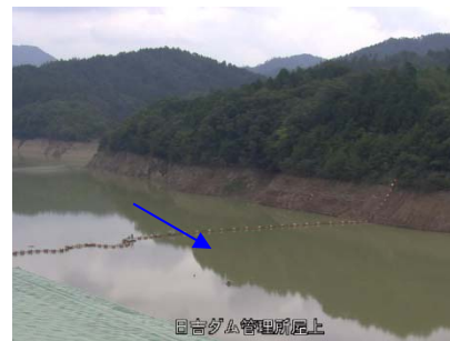
③日吉ダム貯水池
