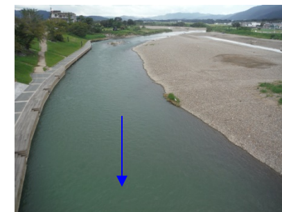
⑨保津橋上流
