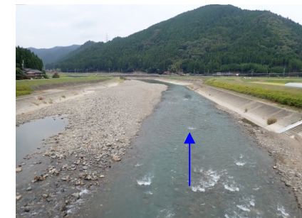
①流入河川(日吉橋下流)
