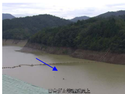
③日吉ダム貯水池
