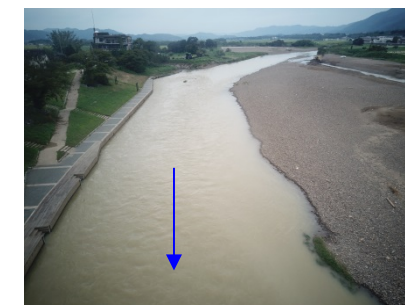
⑨保津橋上流
