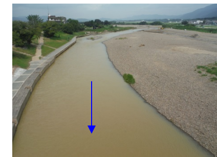
⑨保津橋上流
