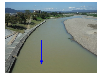
⑨保津橋上流
