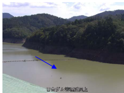
③日吉ダム貯水池
