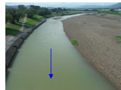
⑨保津橋上流
