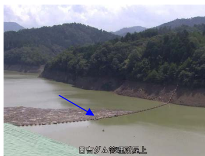
③日吉ダム貯水池
