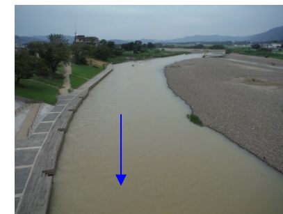
⑨保津橋上流
