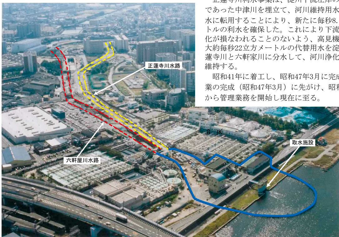
中津川管理室施設全景
