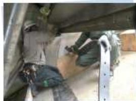
非常用洪水吐きゲート整備（水密ゴムの交換作業）【日吉ダム】
