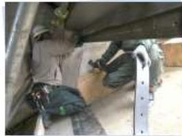
非常用洪水吐きゲート整備(水密ゴムの交換作業)
