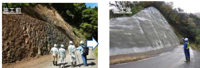
機能回復工事状況(令和4年度実施事例)
