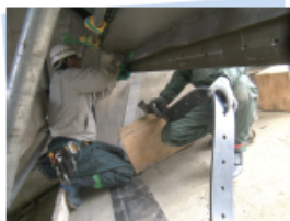
非常用洪水吐きゲート整備(水密ゴムの交換作業) 【日吉ダム】
