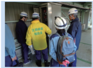
ダム定期検査の実施状況【高山ダム】
