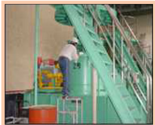
ポンプ設備の点検【正蓮寺川利水施設】
