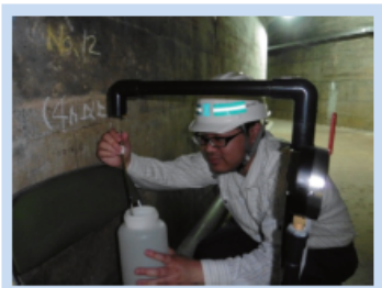
堤体内での漏水量の測定
