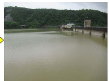
洪水時最高水位に近づく貯水池の状況 (7月6日17時頃 EL150.81m(上昇中))
