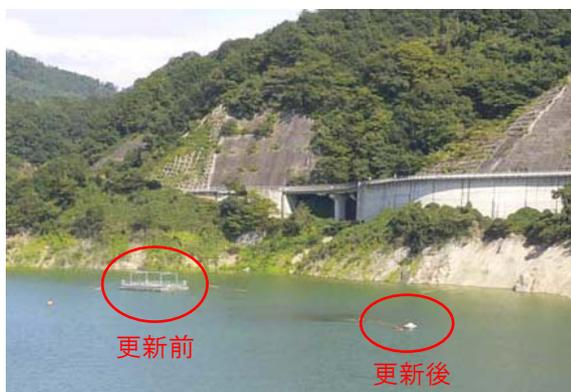
一庫ダムでは、貯水池深層部の溶存酸素の改善を図ることを目的とした深層曝気装置を整備しています。大型の浮上槽のある設備（写真左部分）の老朽化に伴い、湖面景観上、浮上部分の設備が目立たない装置（写真右部分）に更新しました。
