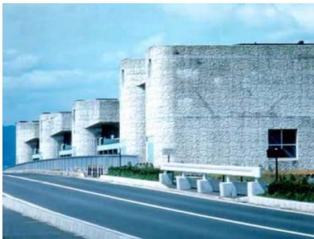
琵琶湖が洪水の際に上昇した湖水が堤内地側に流入することを防止するとともに、渇水時の内湖水位維持のために設けられた施設です。本水門は、径間長だけでも20m以上ある比較的大きな水門施設です。
