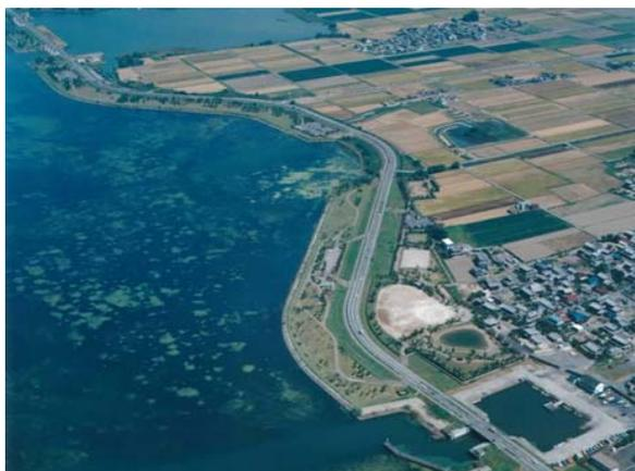
湖岸堤は、洪水時の琵琶湖水位の上昇による氾濫防止のために整備されました。堤防上の管理用道路は県道としても利用され、洪水時の迅速な水防活動や湖辺管理だけでなく、主要幹線道路として琵琶湖の回りの経済活動を支えています。
