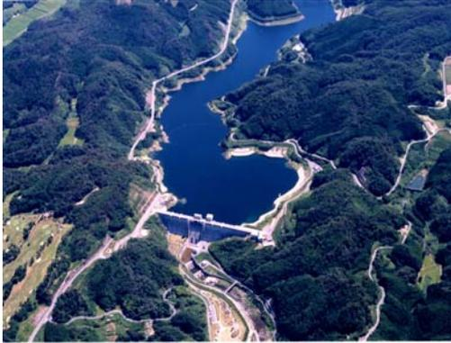
比奈知ダムは、淀川水系木津川の支川名張川の上流部に洪水調節、流水の正常な機能の維持、水道用水の取水、発電を目的とした多目的ダムとして建設され、平成11年4月から管理を開始しています。
