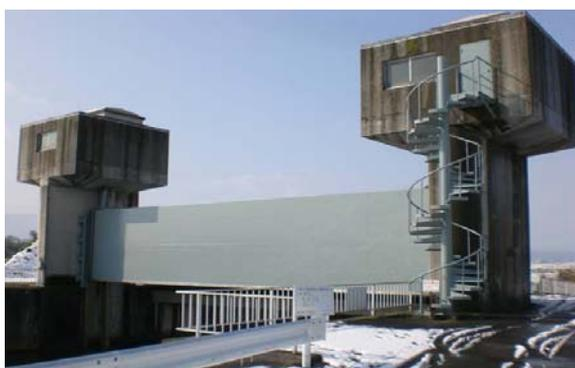
洪水時において琵琶湖水位が上昇した場合に琵琶湖からの逆流を防止し、堤内地の浸水を防ぐために設置している水門で比較的大きなゲートを有しています。
