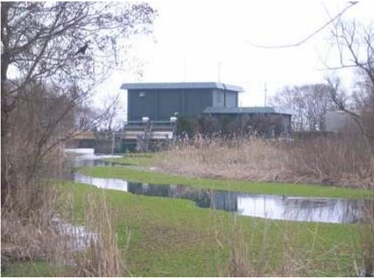
琵琶湖が洪水になり水位上昇した場合に、堤内地側へ湖水が流入しないように河川や水路に設置している水門、樋門を閉鎖しています。排水機場は、その際に堤内地に貯まる水を排水するための施設です。
