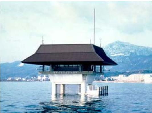
雄琴沖総合自動観測所は、南湖を代表する観測所として水質、水理、気象に関する自動観測を行うため、琵琶湖の湖面上での本格的な観測施設として初めて設置されました。観測所の屋上には、観測機器の電源として太陽光発電パネルを設置しています。
