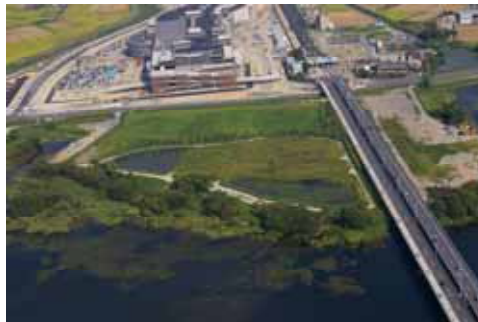
運用開始後の新浜ビオトープ状況
