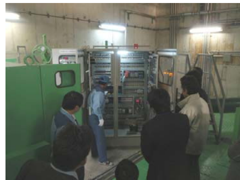
一庫ダム堤体内での説明の様子
