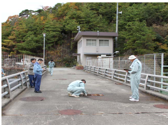
堤体点検（天端変位測量）
