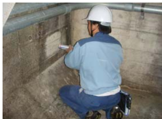
堤体点検（コンクリート健全度調査）
