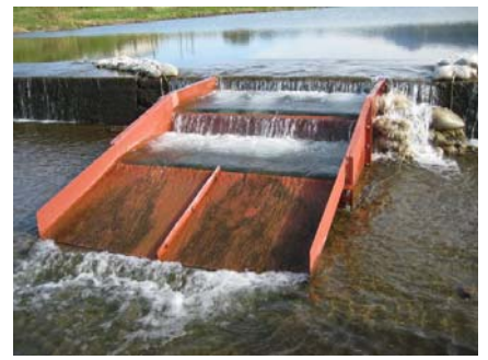
堰堤に設けられた簡易魚道
