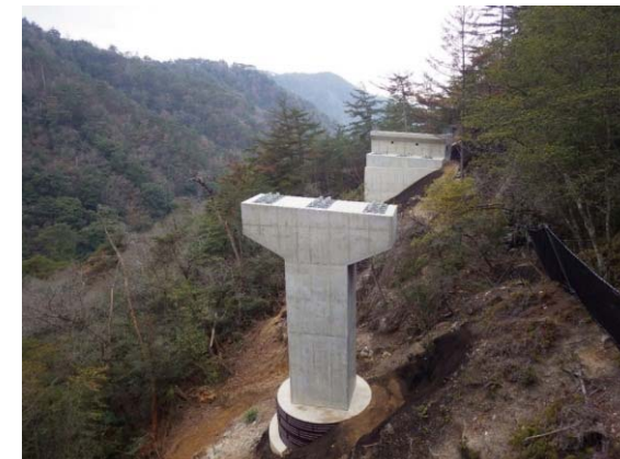
施工中の付替県道大津信楽線 新8号橋
