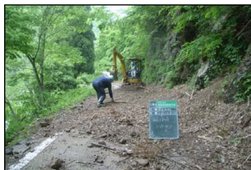
事業地内道路の落石等除去
