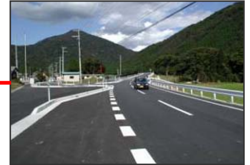
・県道改良工事 H16概成(下丹生～菅並)
