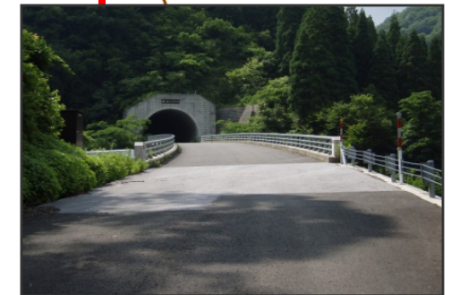
・付替県道妙理谷工区 (あわくじ橋、塩谷トンネル)
