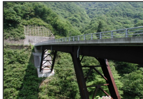
・付替県道妙理谷工区 (施工済概成部上流端、妙理白山橋)
