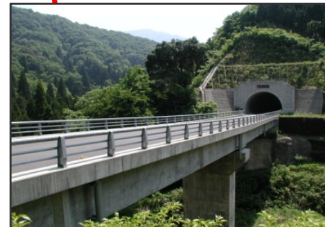
・付替県道妙理谷工区 (下津羅橋、塩谷トンネル)
