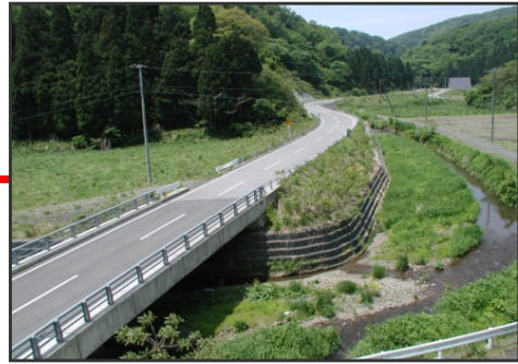
・工事用道路1号線 H17概成(中河内)
