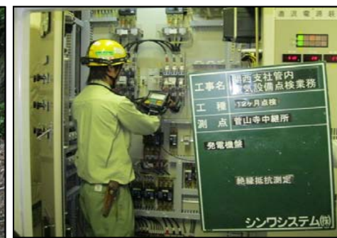
通信設備の点検・保守
