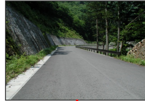
・工事用道路2号線 H16概成(菅並～ダムサイト)
