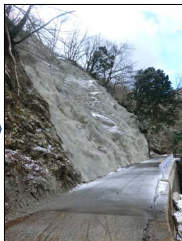
崩落斜面对策(コンクリート吹付)H27.12
