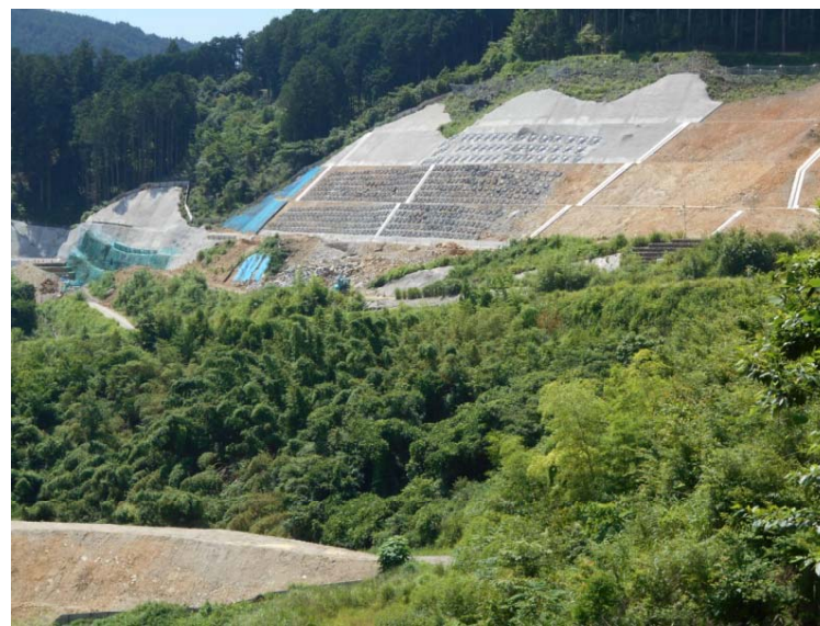
起点側より工事箇所を望む
