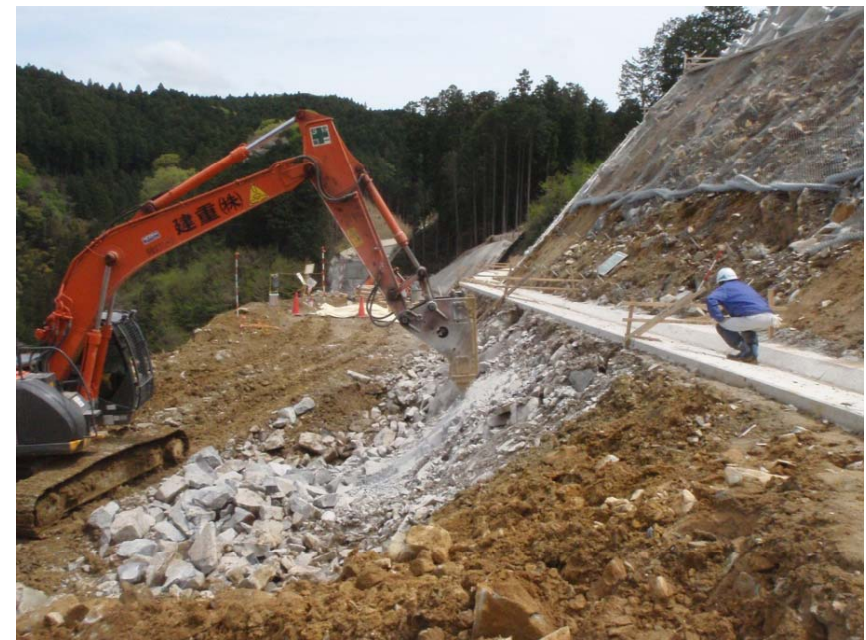
掘削法面への転石発生
