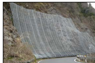
落石防護網工
