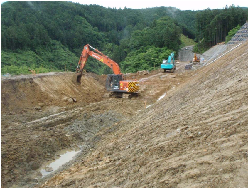
当初想定どおりの法面
