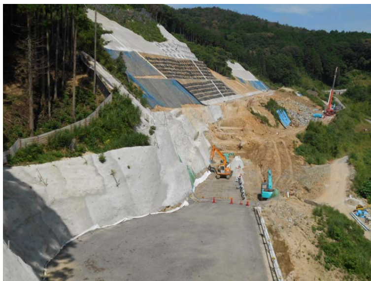
終点側より工事箇所を望む
