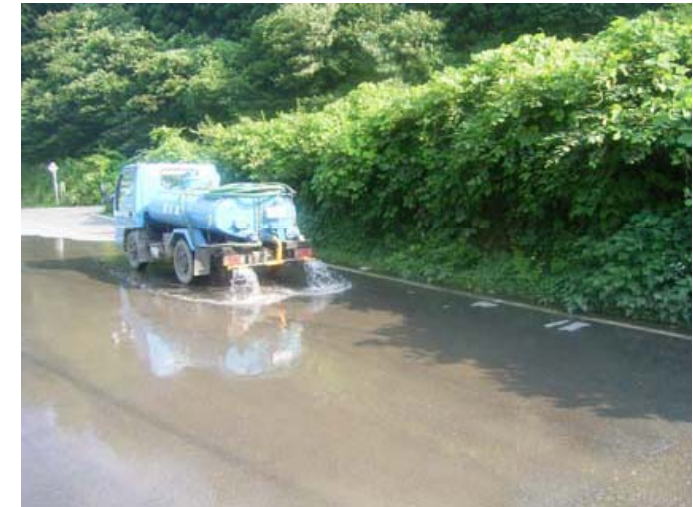
粉じん対策としての散水(既工事での例)
