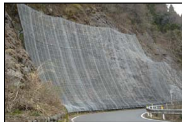
落石防護網工
