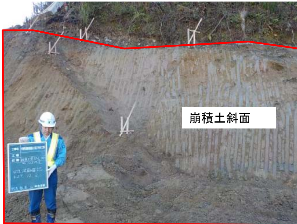
崩積土斜面部の出現状況
