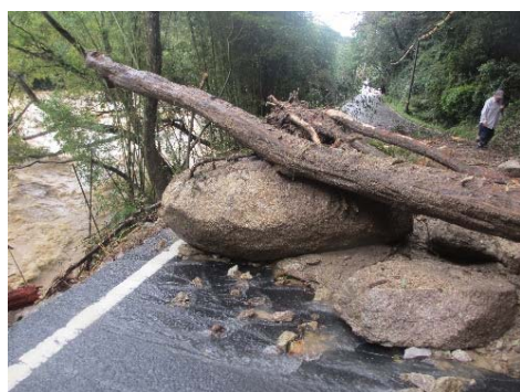
H25台風18号による現道への落石
