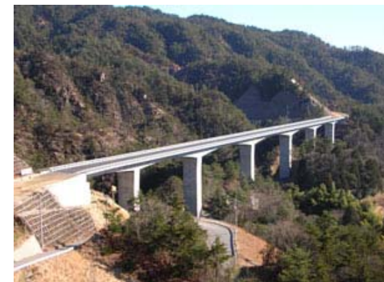
付替県道大津信楽線 24号橋
