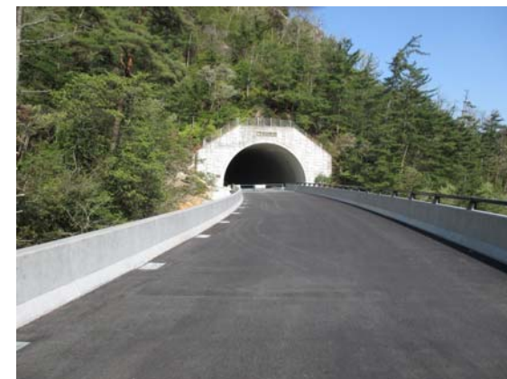
付替県道大津信楽線 新8号橋
