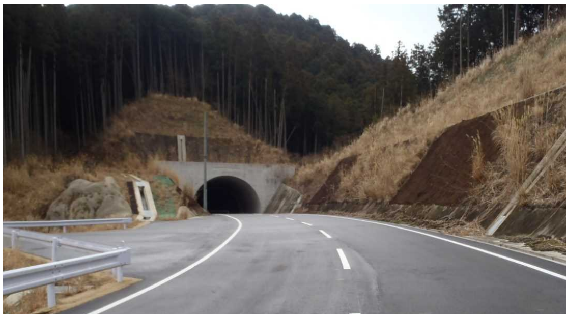
北野トンネル(現況)
