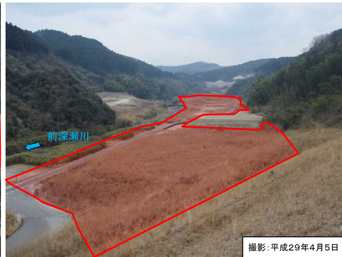
上流工区現況写真
