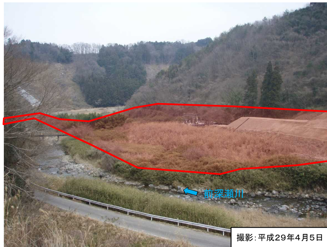
下流工区現況写真
