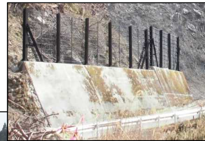
落石防護柵工
