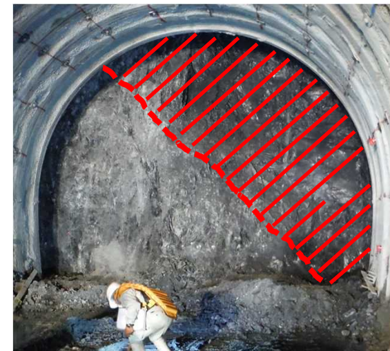
赤斜線部は脆弱層 (破砕帯) を示す
