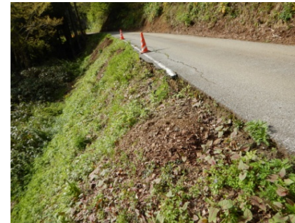
路肩欠損の状況
