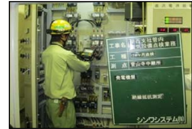
通信設備の点検・保守
