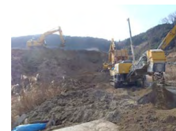
土質改良状況
