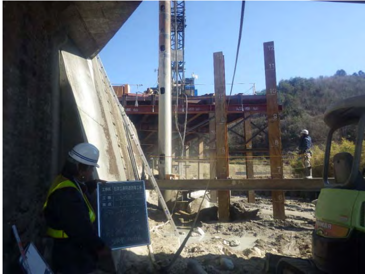
ダウンザホールハンマエ削孔状況
