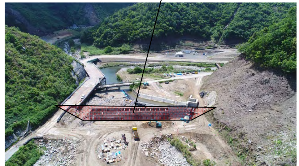
下流から上流仮締切工を望む
