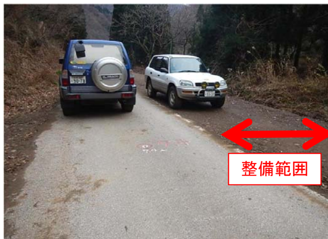
施工後(土工完了)
