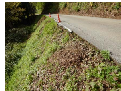
路肩欠損の状況
