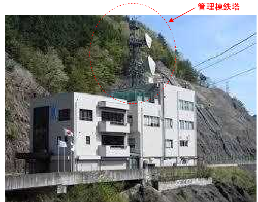
岩屋ダム管理棟鉄塔(イメージ)
