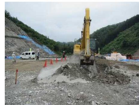
セメント安定処理 施工状況
