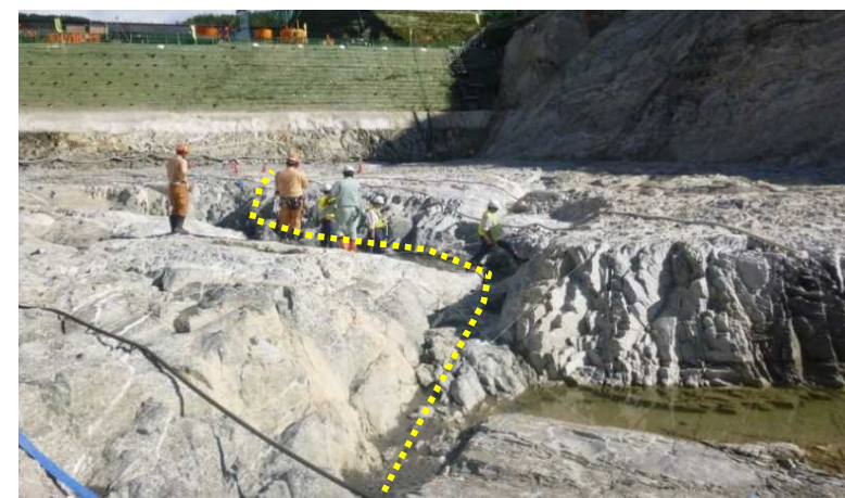
F-5断層 (掘削後)
