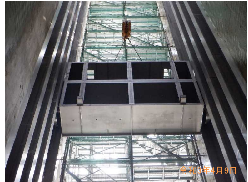
選択取水ゲート設置状況(取水塔内)
