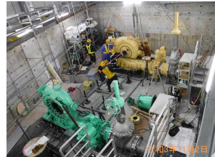
水車据付状況
