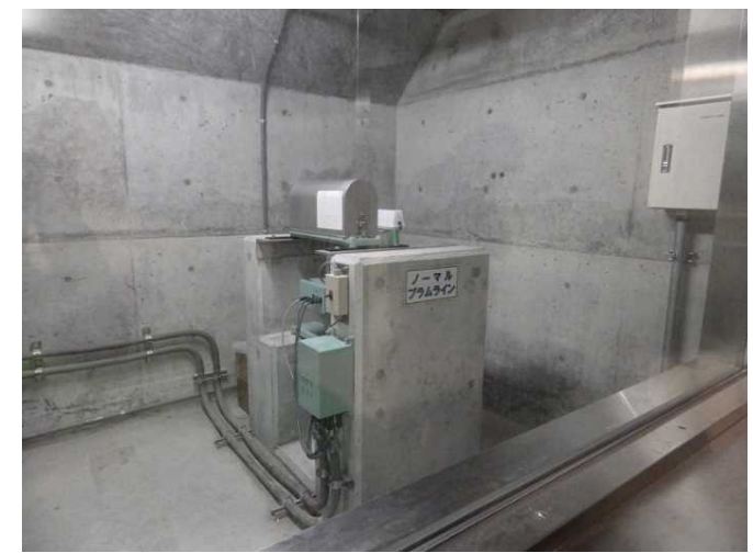
堤体観測イメージ(プラムライン)
