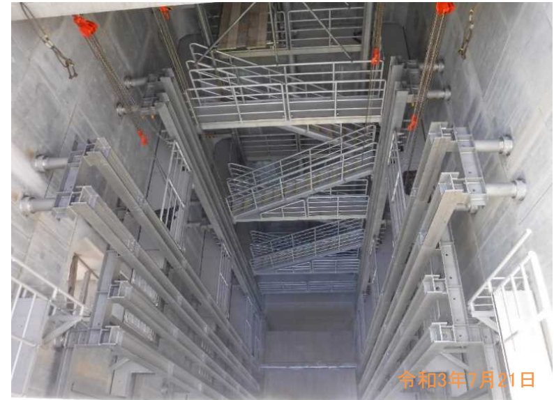
点検歩廊設置状況
