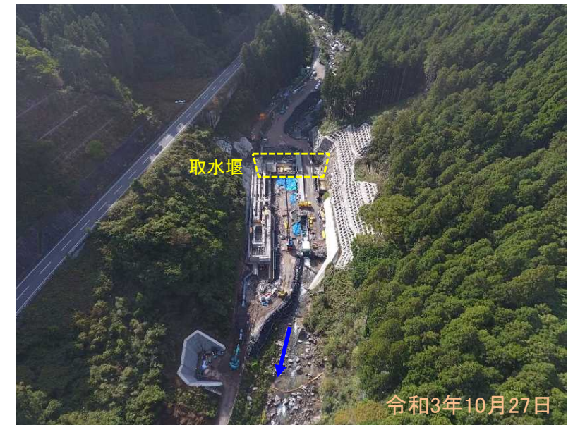
取水堰付近状況
