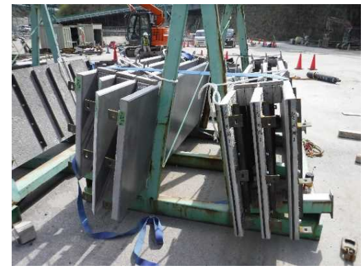
プレキャスト部材仮置状況
