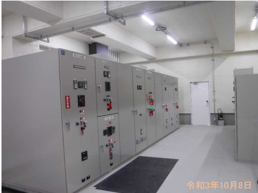
受変電設備設置状況
