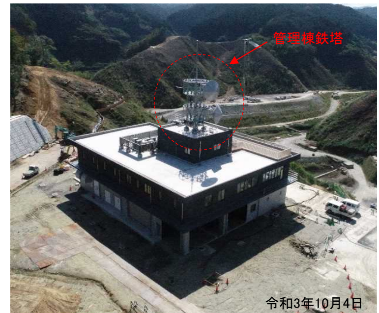
管理棟鉄塔設置状況
