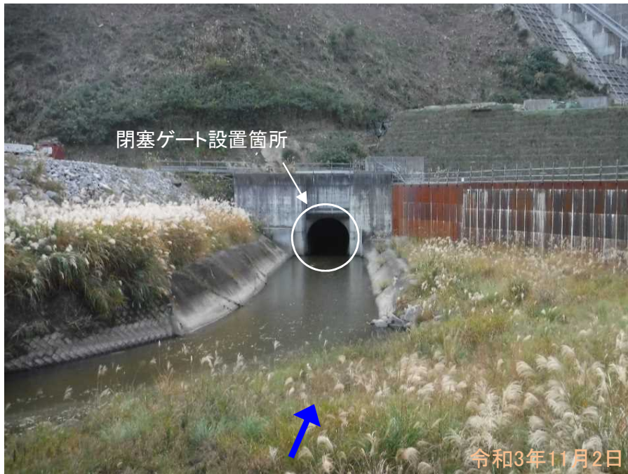
閉塞ゲート設置箇所
