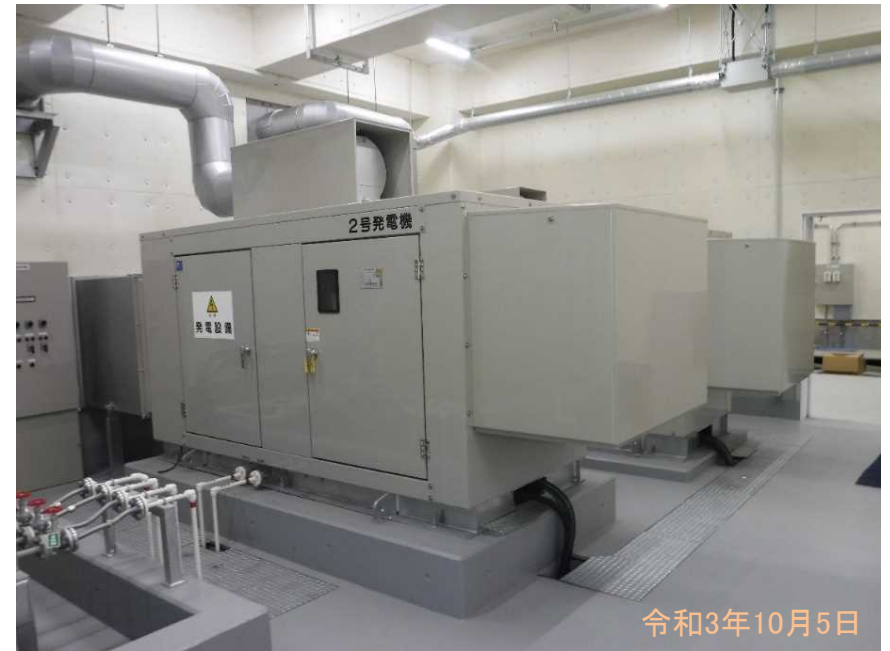
予備発電設備設置状況
