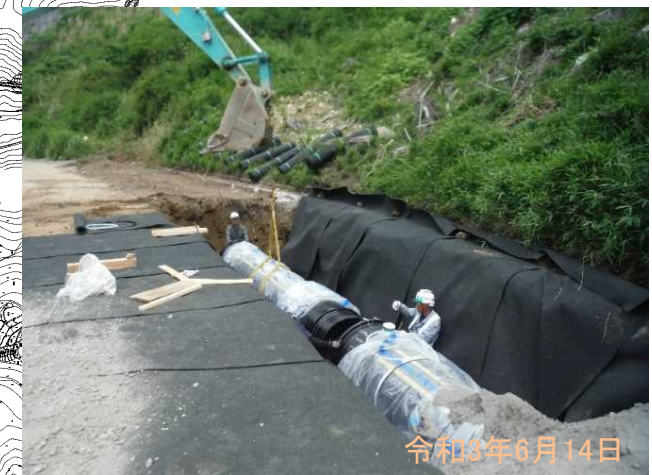
バイパス管施工状況
