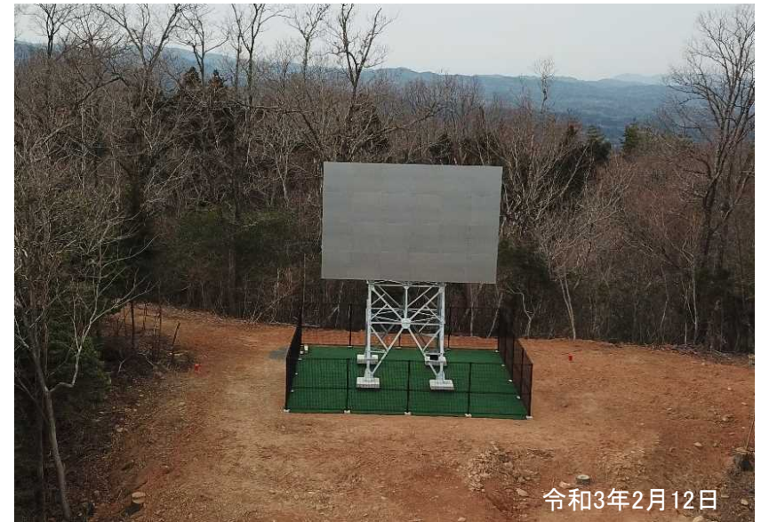
反射板設置状況
