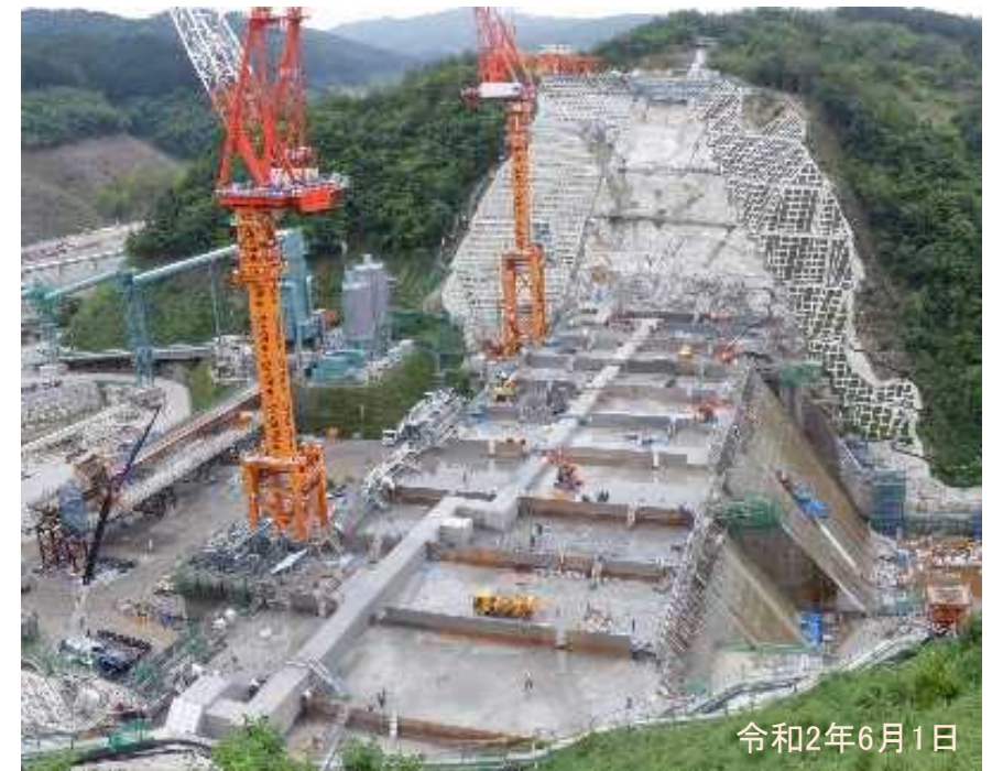
プレキャスト部材設置状況(通廊)
