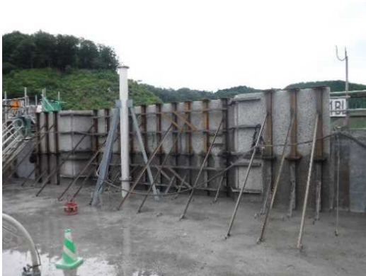
常用洪水吐き上流面(設置状況)
