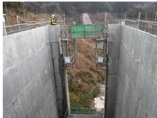
取水設備(取水塔側面部)
