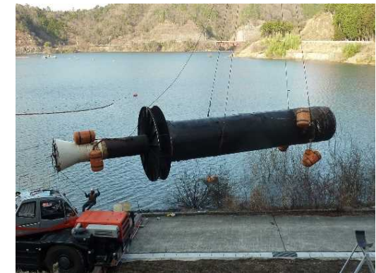
深層曝気設備イメージ(比奈知ダム)
