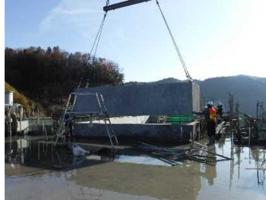
取水設備(取水塔側面部設置状況)
