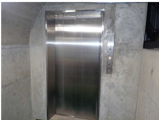
エレベータイメージ(布目ダム)
