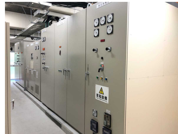
高圧受変電設備
