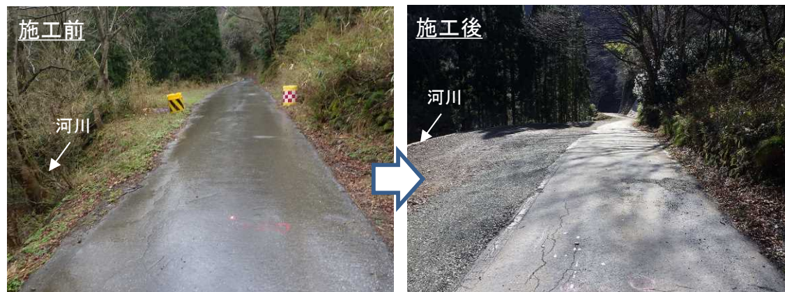
令和2年度 道路復旧状況(鷺見地区)
