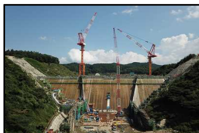
川上ダム(建設中)
