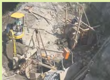
上写真：4号橋完成予想図 下写真：深礎杭掘削状況(H18.9.29撮影)
