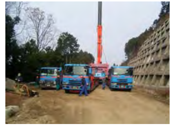
大型クレーン組み立て状況 (H19. 12. 21 撮影)
