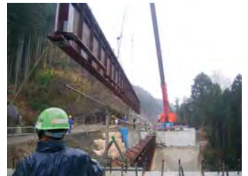
桁架設状況 (H19. 12. 21 撮影)
