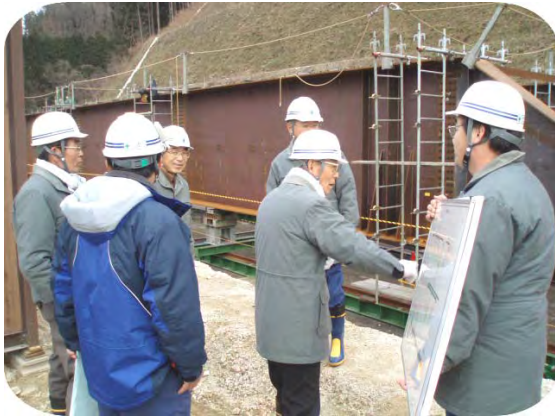
4号橋梁工事現場を視察する西山会長等
