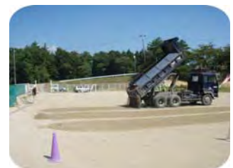
土砂搬入の様子
